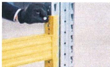
Clip in die seitlichen oberen Lochungen der Balkenkonnectoren einhängen (Lochung oberhalb des Balkenprofils).
